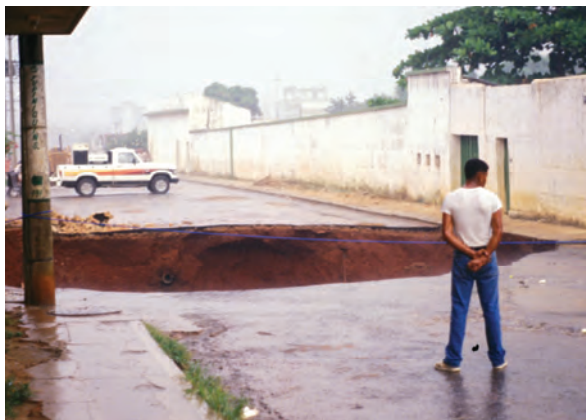
Figura 2. 4 Dolina de colapso em zona urbana. Sete Lagoas, MG, 1988.
